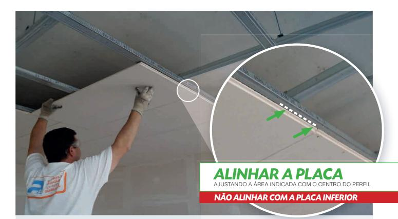
As placas são instaladas ajustando a área inferior do encaixe macho com o centro do perfil TC. Não devemos nos alinhar com a placa inferior, pois em alguns casos ela pode ser um pouco menor. Desta forma, evitamos acumular erros e mover perfis uma vez colocados.
