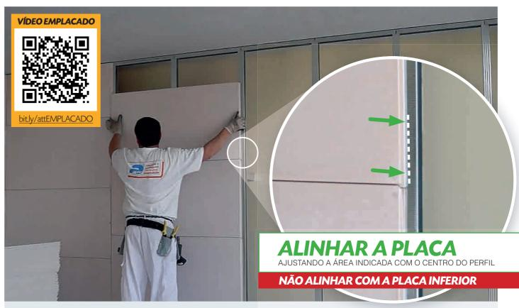
As placas são instaladas ajustando a área inferior do encaixe macho com o centro do montante. Não devemos nos alinhar com a placa inferior, pois em alguns casos ela pode ser um pouco menor. Desta forma, evitamos acumular erros e mover perfis uma vez colocados.
