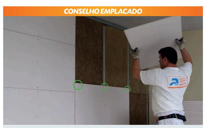
Tanto no tecto como na divisória, é conveniente não colocar os três parafusos superiores para ajustar a placa seguinte, para favorecer o encaixe das placas. O encaixe macho entra mais facilmente sem ser pressionada pela placa inferior.
